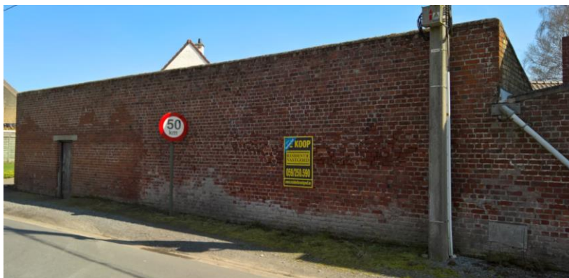
Dit gebouw was eerste een breiatelier en later een diamantslijperij ondergebracht (Foto: G. Staelens).
