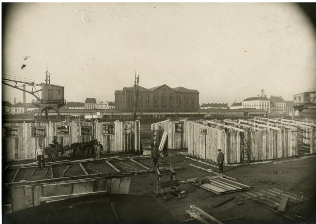
Bouw van Genter Baracken in Gent op de Schipperskaai aan het Handelsdok, tegenover het Entrepot aan het Stapelplein (1915-1916) 154 .
