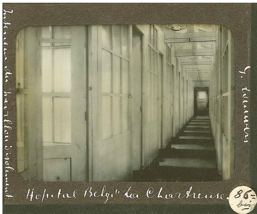
Glasplaat 86bis: Intérieur du pavillon d'isolement – Interieur van het quarantaine-paviljoen.
